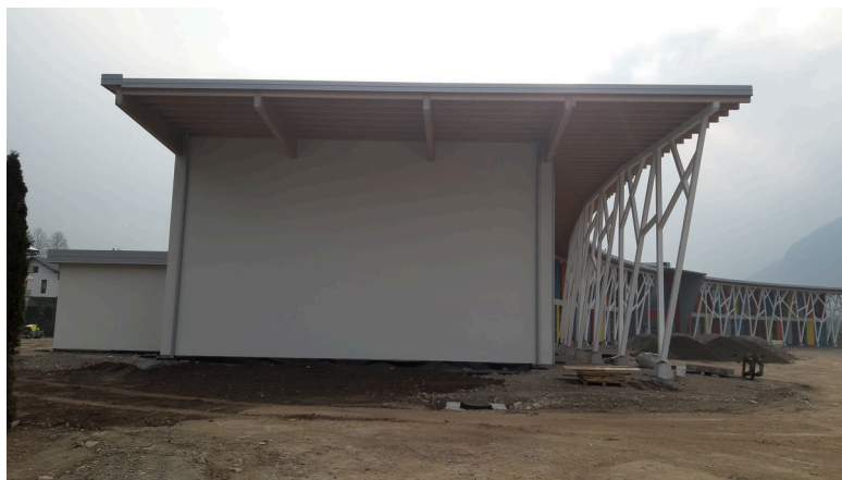
Foto: facciata ovest
